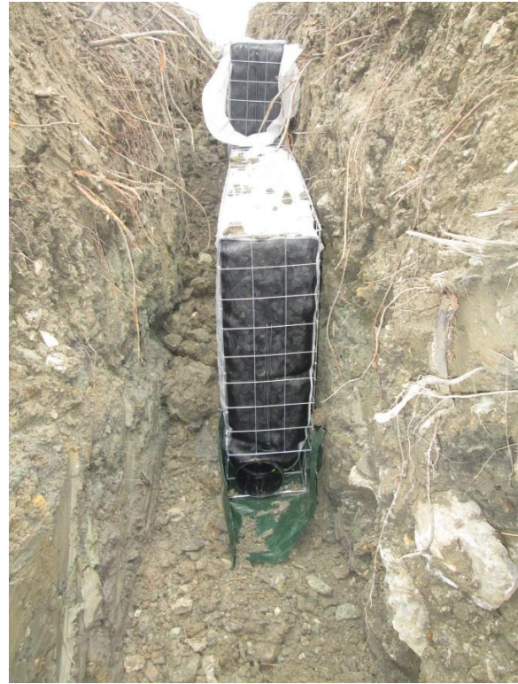
Abbildung 5. In den Graben abgesenktes
