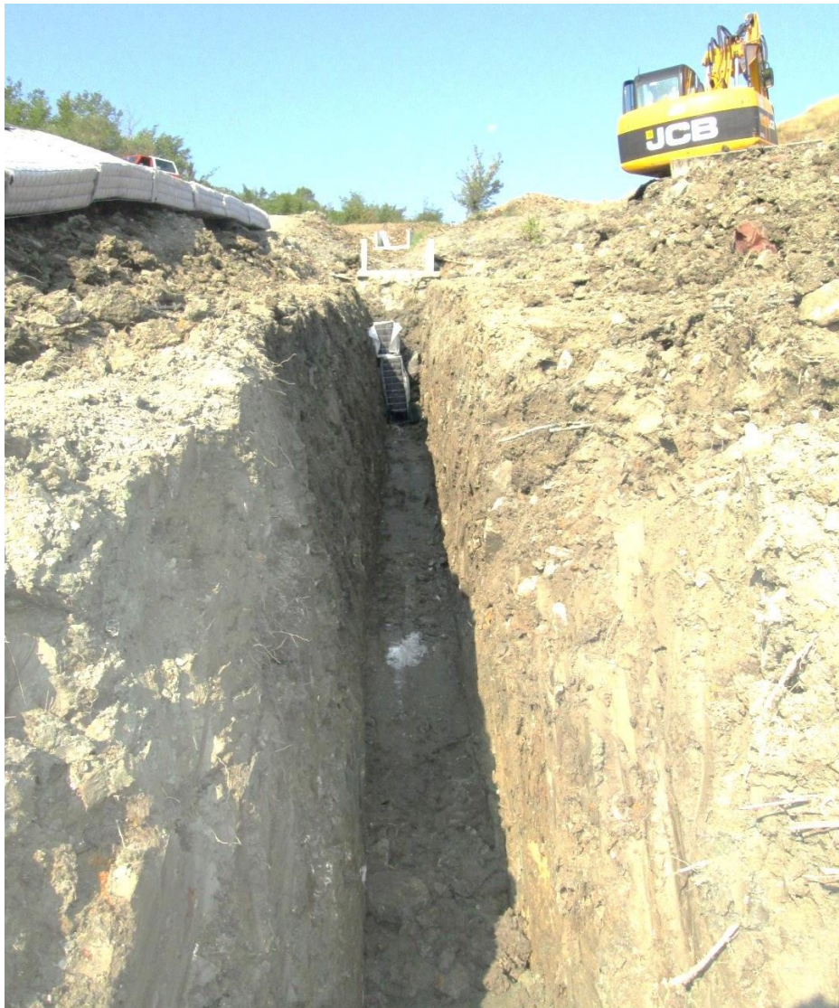
Abbildung 2. Mit einem Bagger ausgehobener Graben, etwas breiter als das Entwässerungssystem
