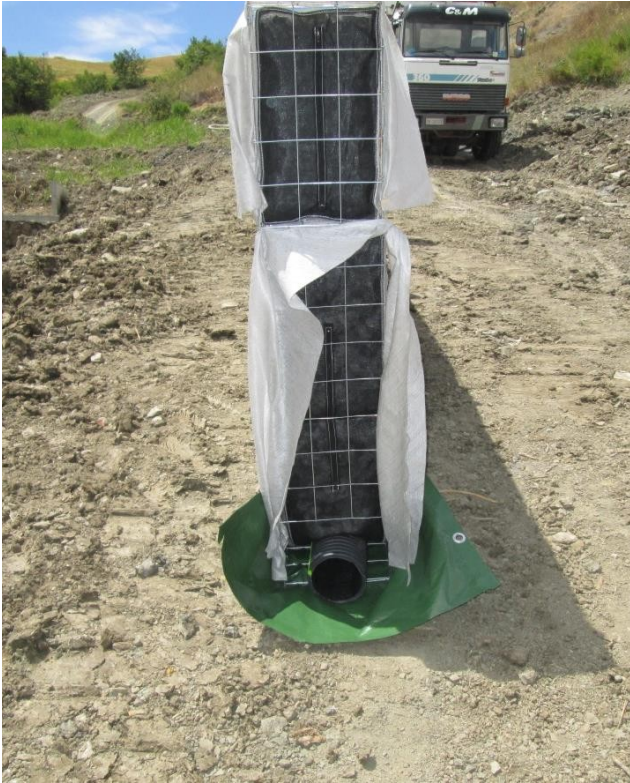
Abbildung 4. Gesamtansicht des Drainagesystems mit Ummantelung Entwässerungssystem DRENTER PIPE und DRENTER 500 korrekt verbunden
