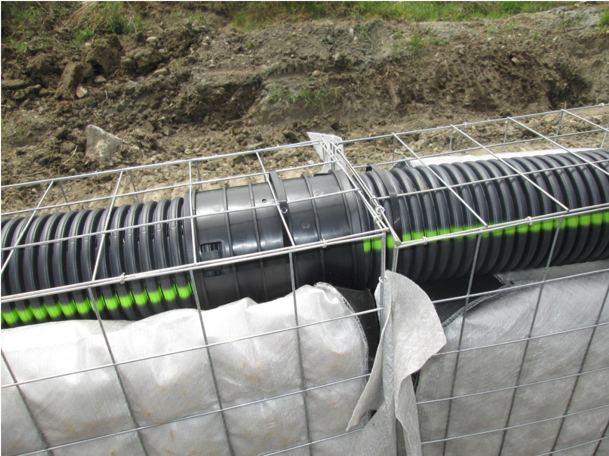
Abbildung 3. DRENTER PIPE-Platten, die mit Muffen verbunden wurden, um eine perfekte hydraulische Abdichtung zu gewährleisten
