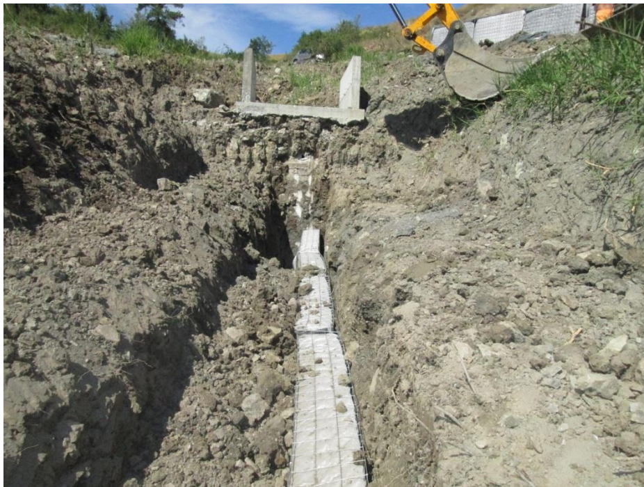
Abbildung 6. Gesamtansicht des im Untergrund stabilisierten Entwässerungssystems, bevor es vollständig abgedeckt wurde
