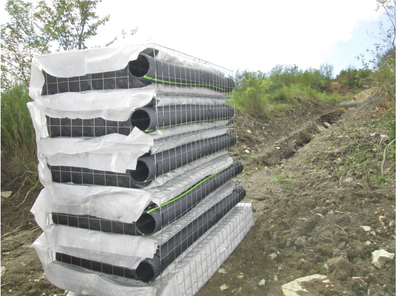
Figura 1. Vista general del producto DRENTER PIPE, antes de ser unido y colocado en obra
