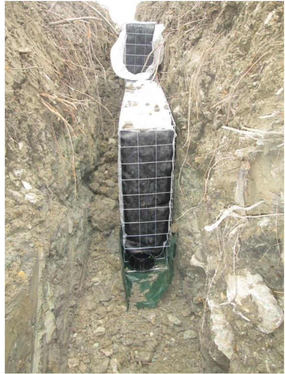
Figura 5. Sistema de drenaje colocado en la
