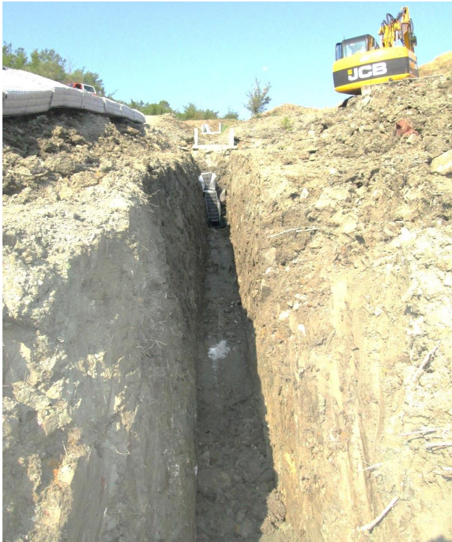
Figura 2. Zanja realizada con excavadora, ligeramente más ancha que el sistema de drenaje
