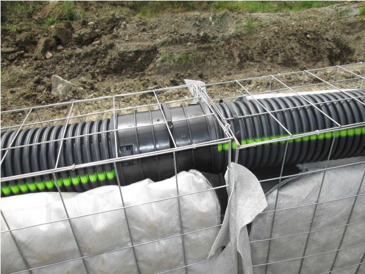
Figura 3. Paneles DRENTER PIPE unidos mediante manguitos para garantizar una estanqueidad hidráulica perfecta
