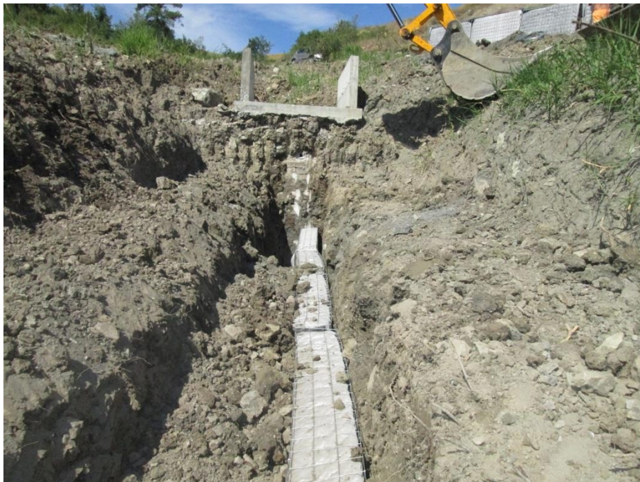
Figura 6. Vista general del sistema de drenaje estabilizado en el subsuelo, antes de ser completamente cubierto
