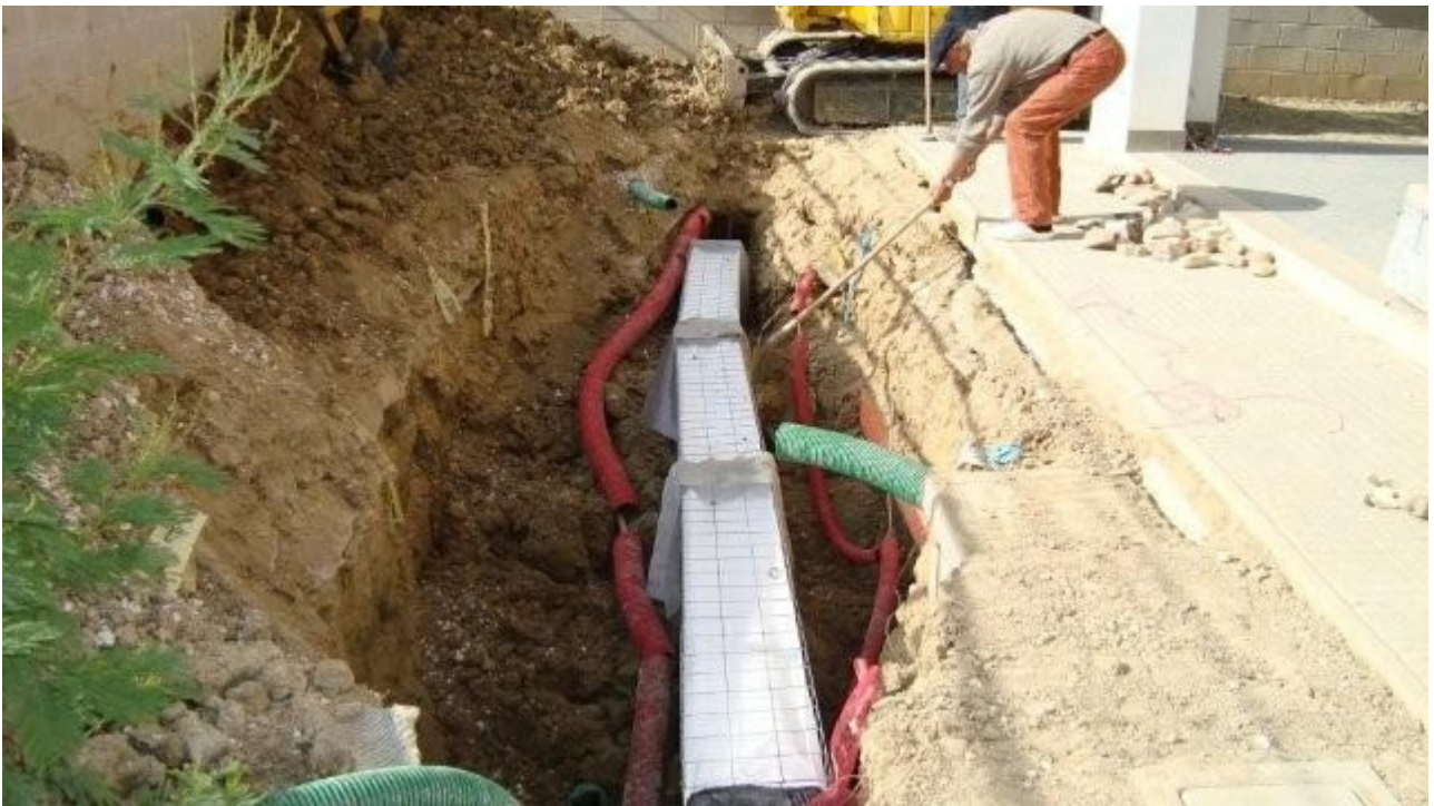
Unmittelbar nach der Verlegung
