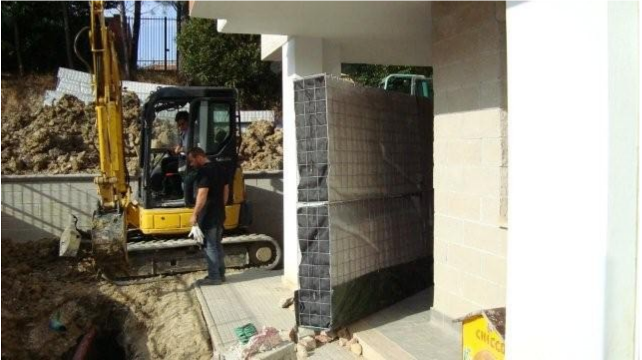
Die DRENTER-Module vor dem Einbau in den schmalen Graben
