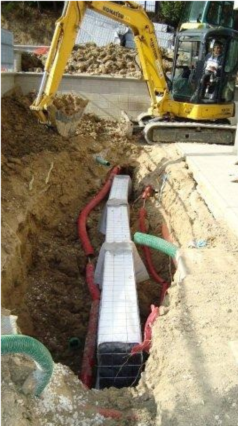
Phasen der Verfüllung mit einem Bagger
