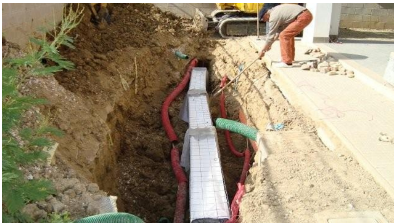
Inmediatamente después de la colocación
