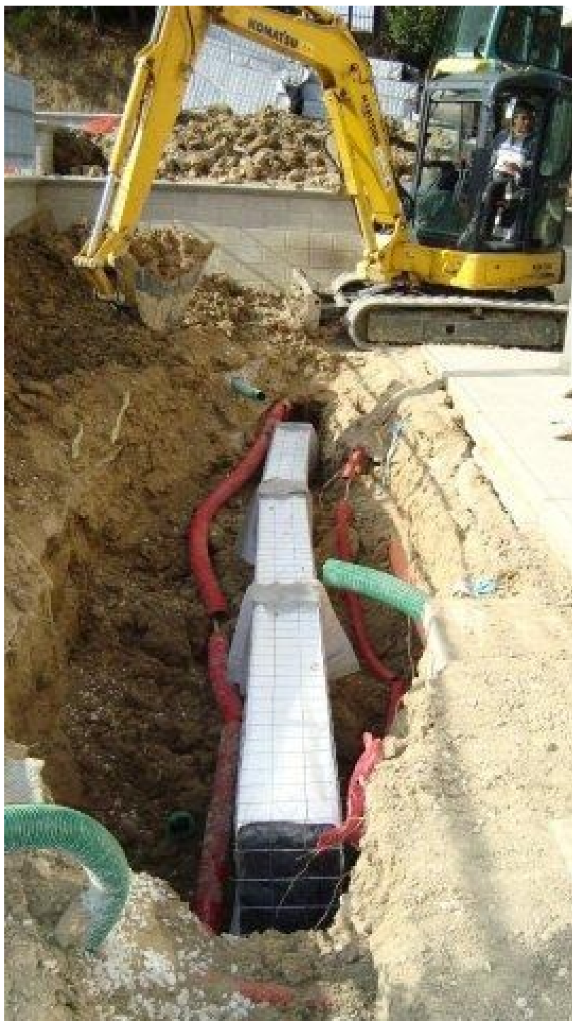
Fases de relleno con excavadora.
