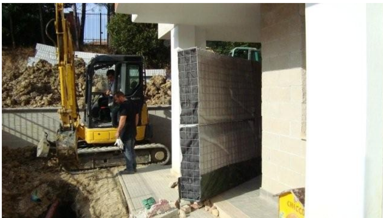
Los módulos DRENTER antes de su colocación en una zanja estrecha
