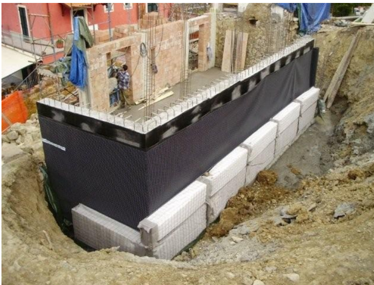
Weitere Fotos von der Baustelle
