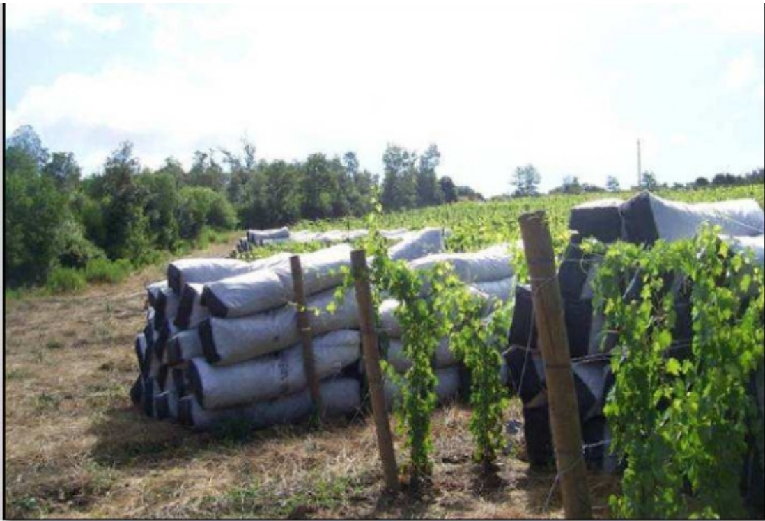
Abbildung 2 – Verwendete flexible Drainagesäcke aus Vliesstoff, Modell IDROSAC 500
