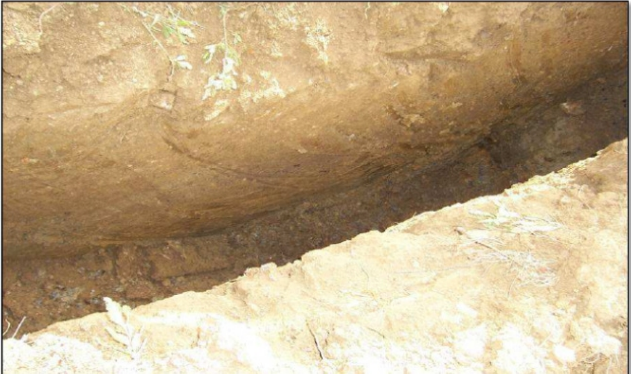
Abbildung 3 – Mit einem Bagger durchgeführte Aushubarbeiten für die Verlegung des IDROSAC 500-Systems auf dem Weingut in Montalcino (SI).
