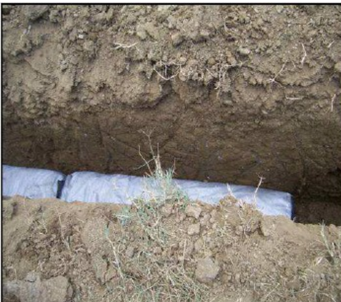
Abbildung 5 – Positionierung der Drainagesäcke IDROSAC 500 am Boden des Grabens
