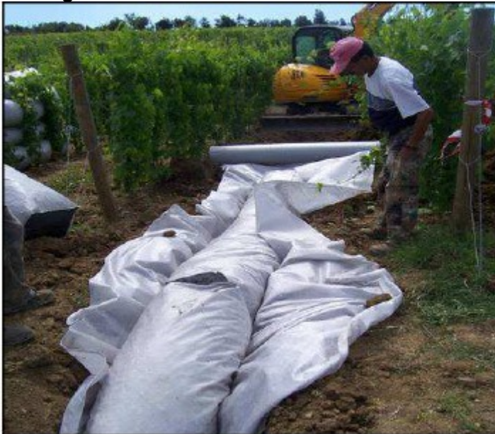
Abbildung 6 – Manuelles Auskleiden der Drainagesäcke mit TNT im Graben
