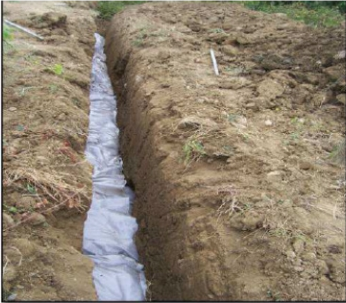
Abbildung 8 – Manuelles Verschließen des Vliesstoffs über dem Drainagesack IDROSAC 500
