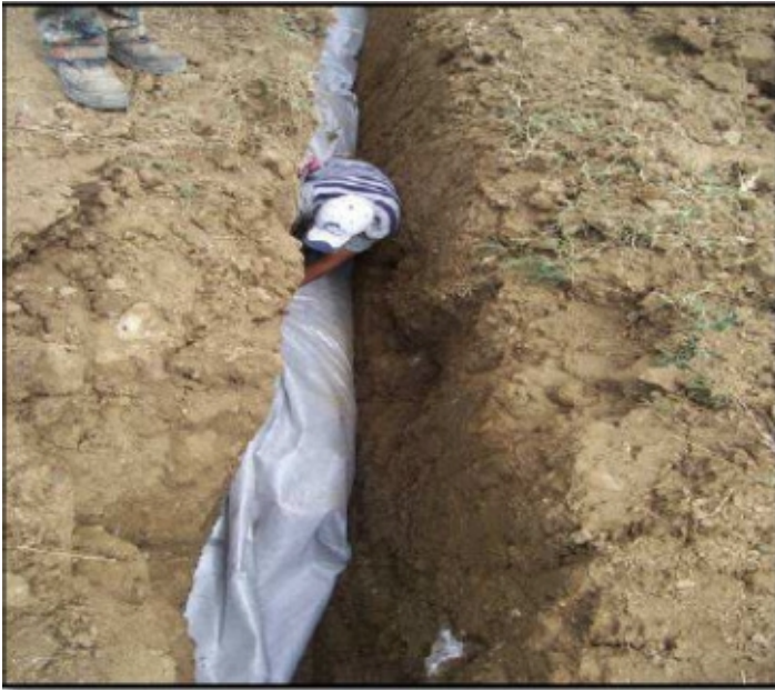
Figura 6 - Operación de recubrimiento de los sacos drenantes con TNT realizada manualmente dentro de la zanja
