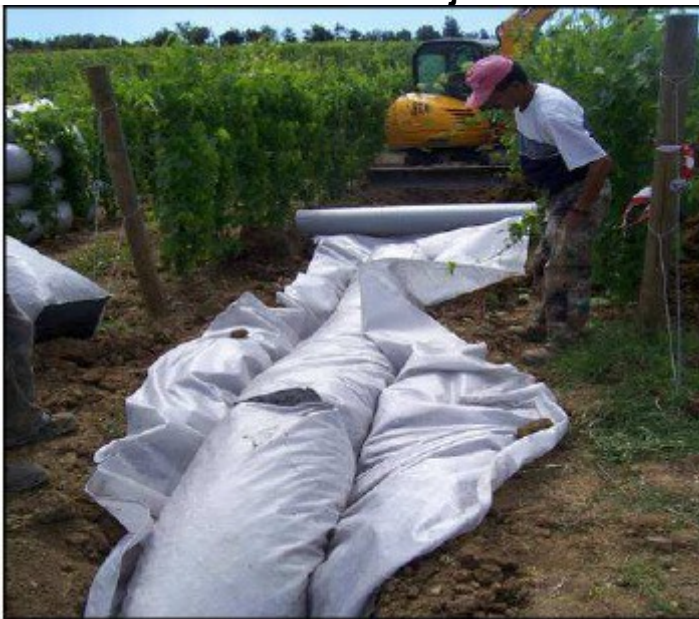
Figura 6 - Operación de recubrimiento de los sacos drenantes con TNT realizada manualmente dentro de la zanja
