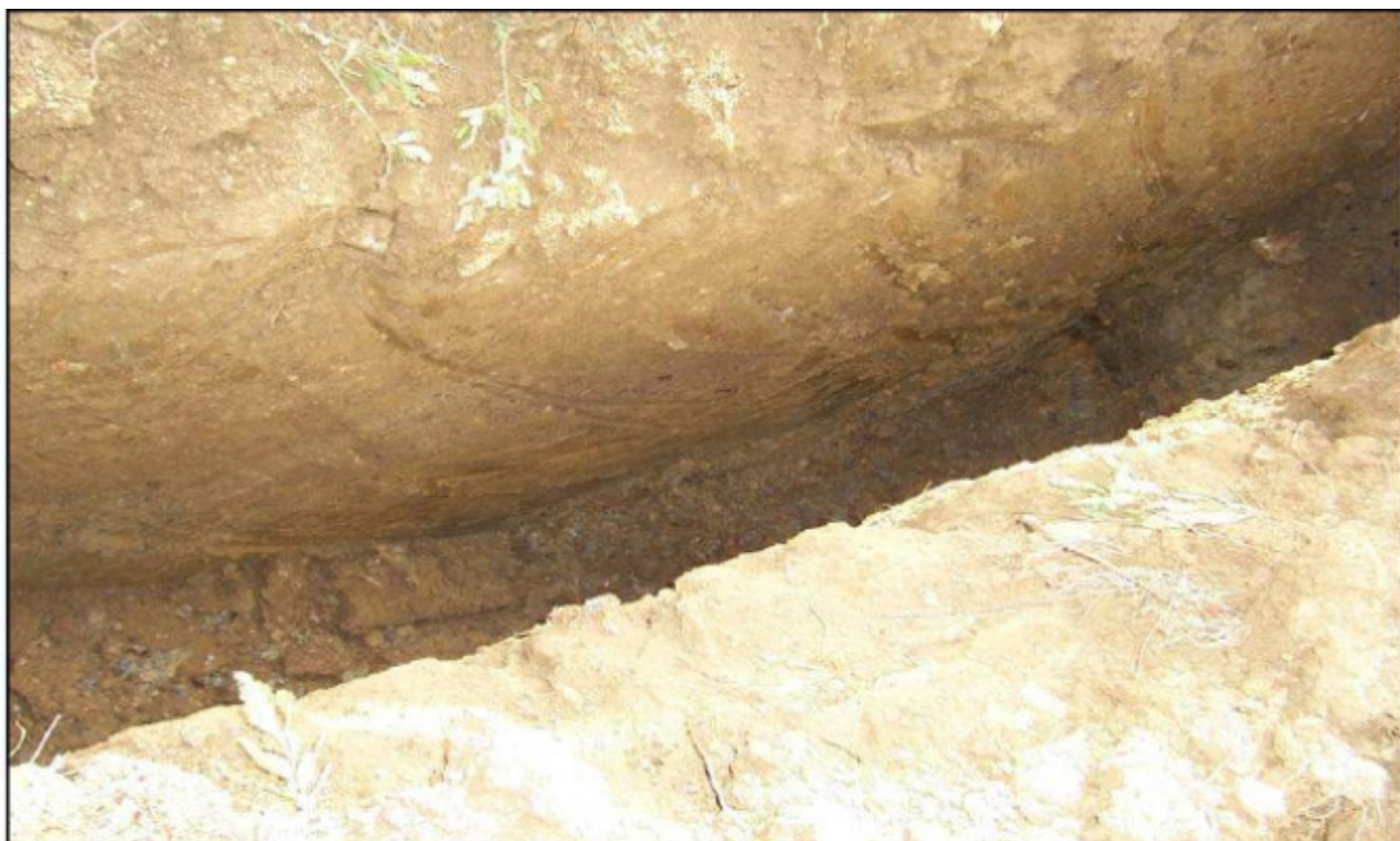
Figura 3 - Excavación realizada con excavadora mecánica para la instalación del sistema IDROSAC 500 en la finca de Montalcino (SI).
