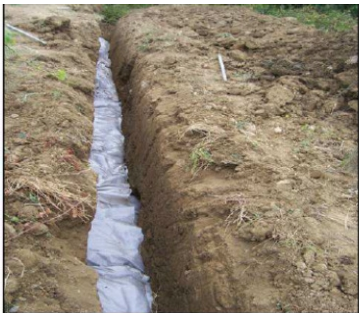
Figura 8 - Cierre manual del TNT sobre la bolsa drenante IDROSAC 500
