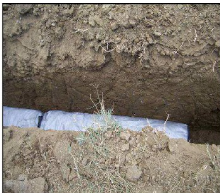
Figura 5 - Colocación de los sacos drenantes IDROSAC 500 en el fondo de la zanja
